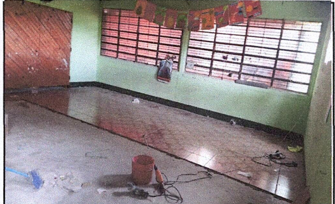
Foto 2: Mejoramiento de piso
