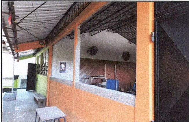
Foto 3: Mejoramiento de ventanas
