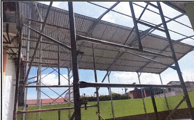
Foto 1: Colocación de láminas
