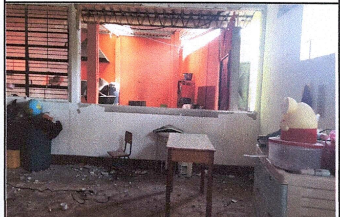
Foto 4: Mejoramiento de ventanas
